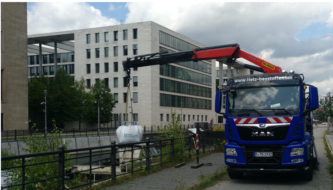
Abbildung 10: Lieferung der neuen Filtermaterialien für Filter 3 und Filter 4
