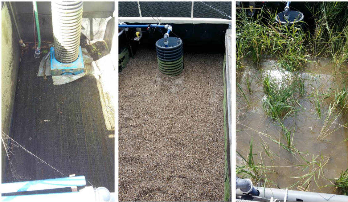
Abbildung 9: Umbau Filter 3; Leerzustand, Befüllung mit neuem Filtermaterial und Endzustand nach Bepflanzung (von links nach rechts)
